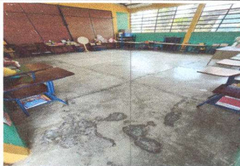
Foto 2: Sustrucción de piso de cemento liquido por piso ceramico
