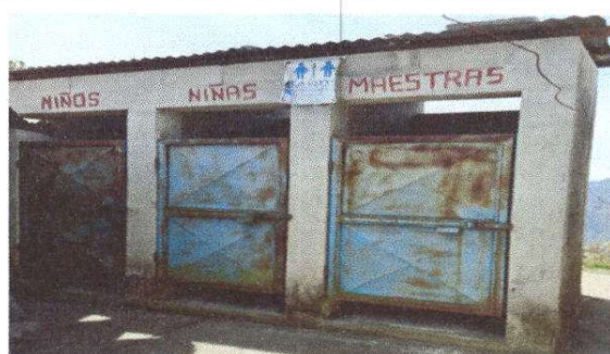
Foto 4: Mantenimiento a estructura (lijado, cambio de tubo , cepillado, sujeciones, aplicación de pintura) a puertas servicios sanitarios
