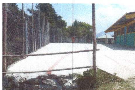
Foto 6: Reparación de muro perimetral de block con tubo hg y malla galvanizada, soleras intermedias y columnas.
