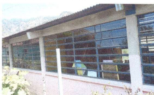
Foto 3: Pintura en muros exteriores e interiores
